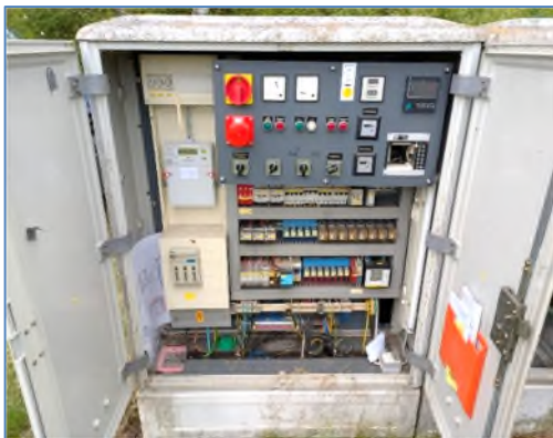
Oben: Blick auf die abgängigen Schalt- und Übertragungsanlagen in B 10 und B11
