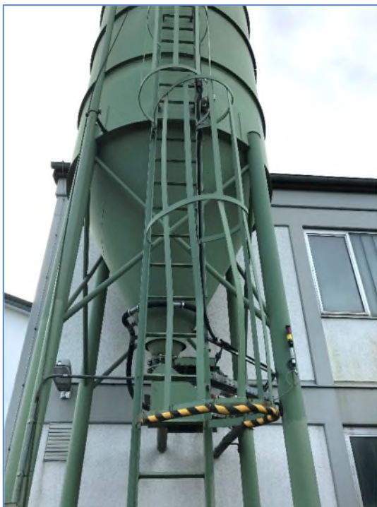
Erneuerung Steigleiter und Fallschutz am Kalksilo der KA Lollar [links alt/rechts neu]
