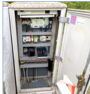
Oben: Blick auf die abgängigen Schalt- und Übertragungsanlagen in B 10 und B11
