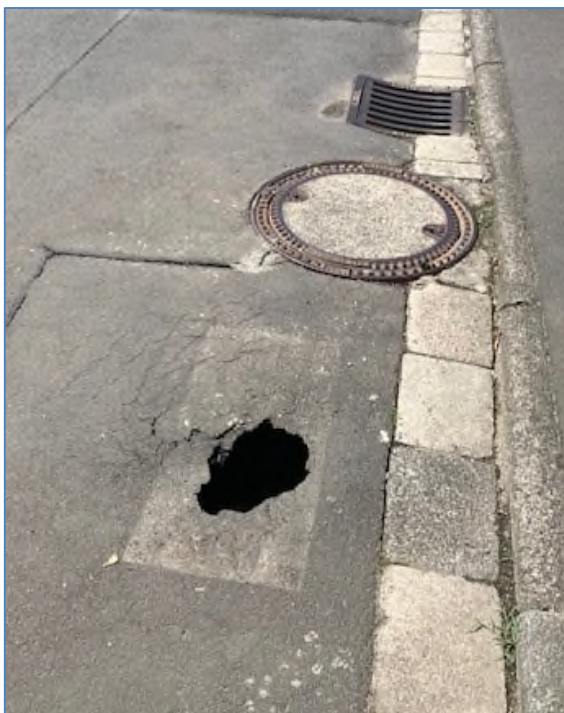
Links: Blick auf den Deckeneinbruch
