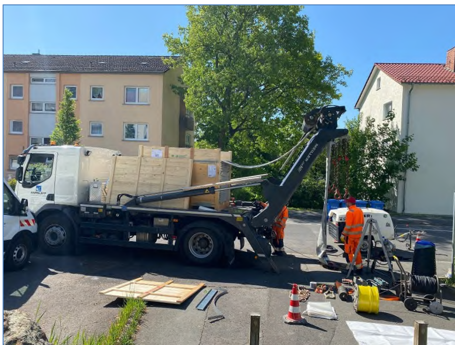
Unten: Einzug der Schlauchliner mittels Winde vom Lkw aus
