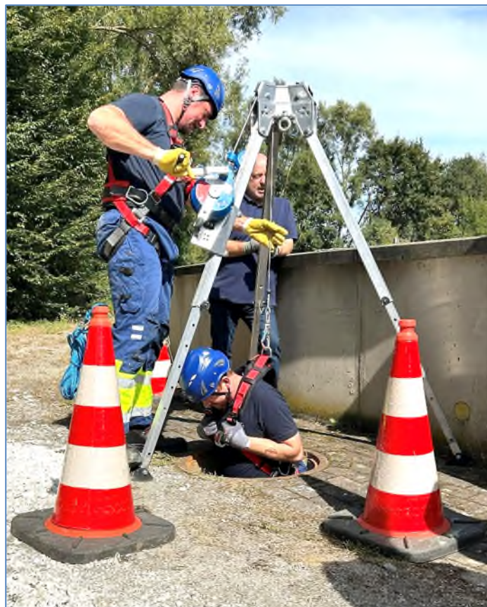
Einstieg in umschlossene Räume und Behälter „in situ“
