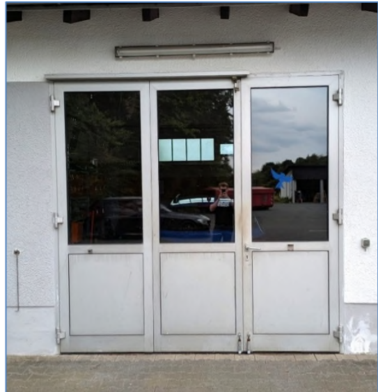
Oben: Blick auf die abgängigen Falttore an Werkstatt und Garage Notverglasung am Werkstatttor aufgrund eines Einbruchsversuchs Unten: Blick auf die neuen Rolltoranlagen
