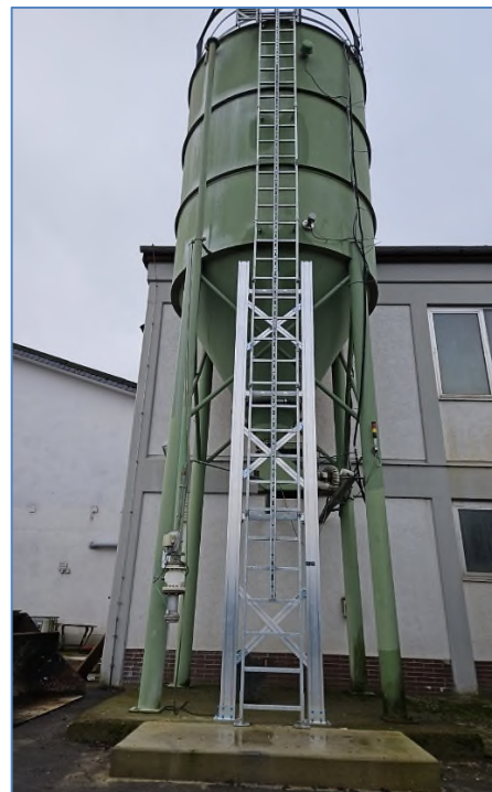
Erneuerung Steigleiter und Fallschutz am Kalksilo der KA Lollar [links alt/rechts neu]
