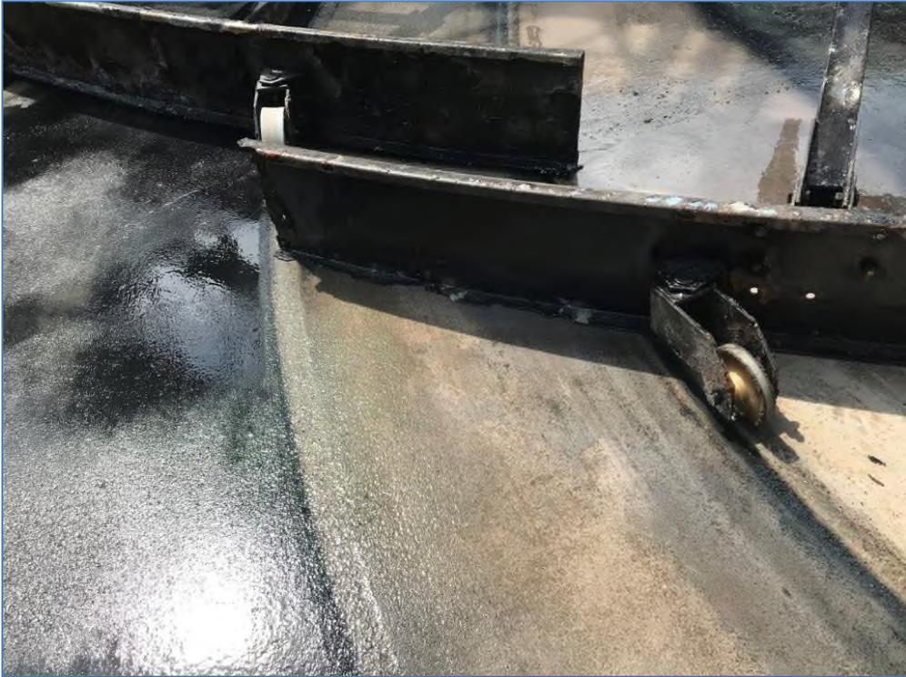
Bild oben: Verschlissene Räumschilde und defekte Laufrollen im Nachklärbecken
