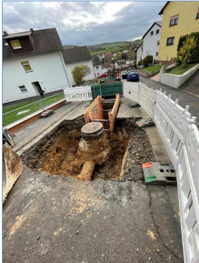
Bild oben: aufgegrabener Deckeneinbruch
