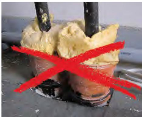
**Regelwerke fordern, dass Gas-, Wasser-, Strom-, Telekommunikations- und Fernwärmeleitungen gas- u. wasserdicht in Gebäude eingeführt werden müssen!**
