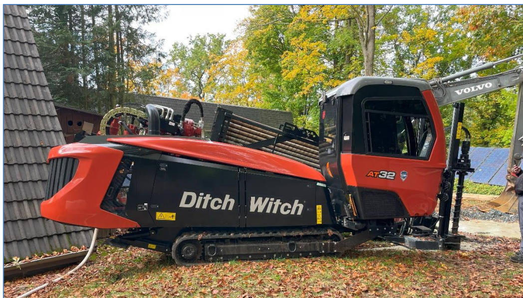
Unten: Blick auf das Bohrgerät
