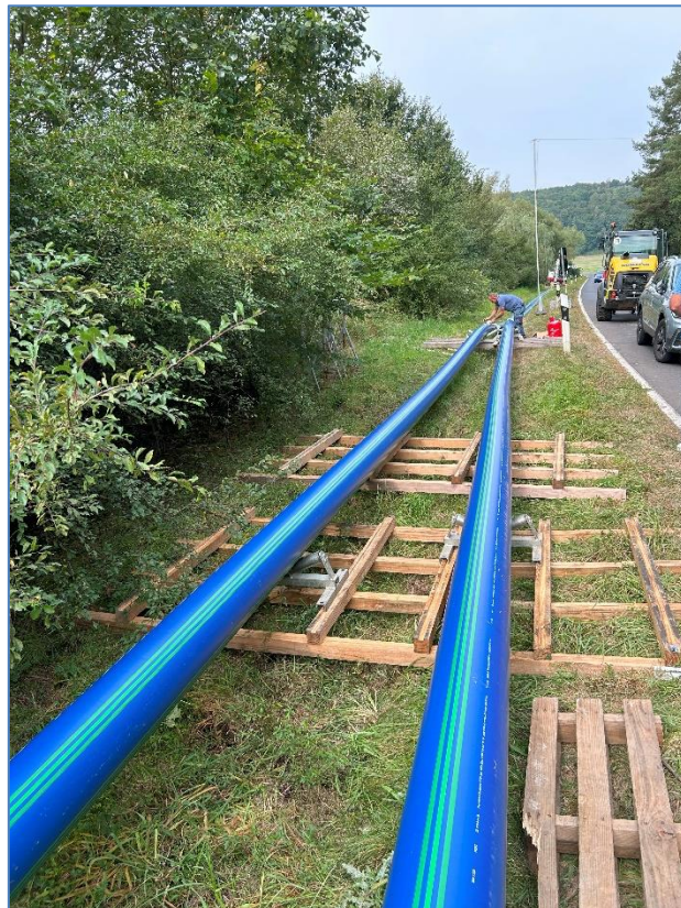
Versorgungsgebiet Staufenberg-Treis Erneuerung der Transportleitung Mainzlar nach Treis - OD 225 - PE Oben: Schweißautomaten für die Rohrverbindungen Unten: Verbundene Rohrstränge
