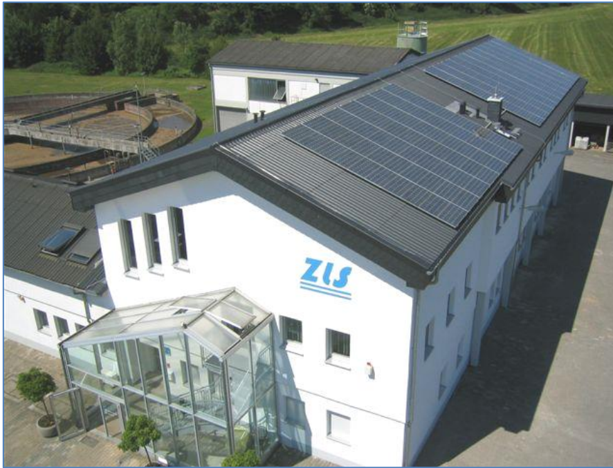
Betriebszentrale Lollar → Photovoltaikanlage
