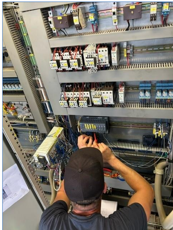
Unten: Blick auf den ZLS-Betriebselektroniker in der Umbauphase
