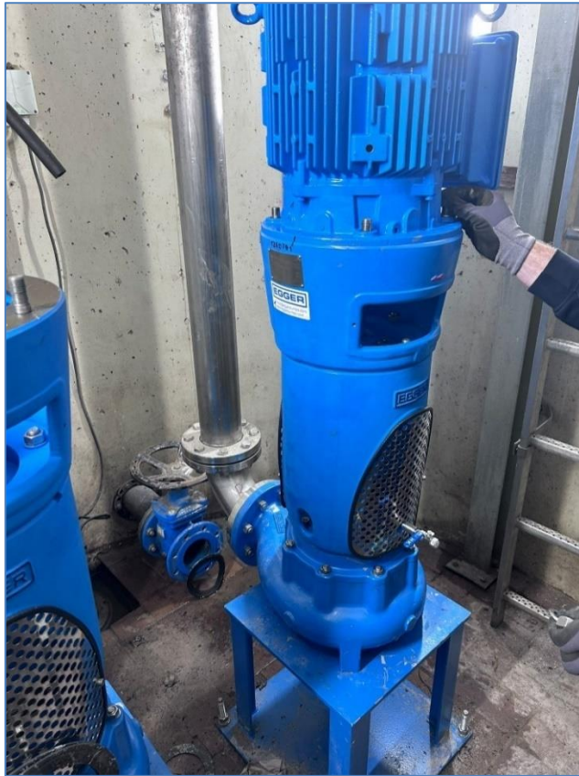
Oben: Blick auf die neuen senkrechten Abwasserpumpen am Pumpwerk B 13 "Treis" Unten: Beengte Verhältnisse im Pumpwerk B 13 beim Einbau des Druckrohrsatzes
