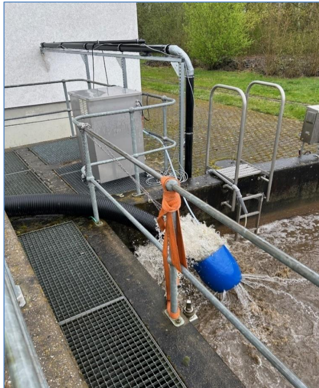
Oben: Ausgleich Höhenunterschied mit Beton-Legos (links)/ Fliegende Leitung (rechts) Unten: Improvisierte Probenahmestelle vor Einlauf in die Belebung
