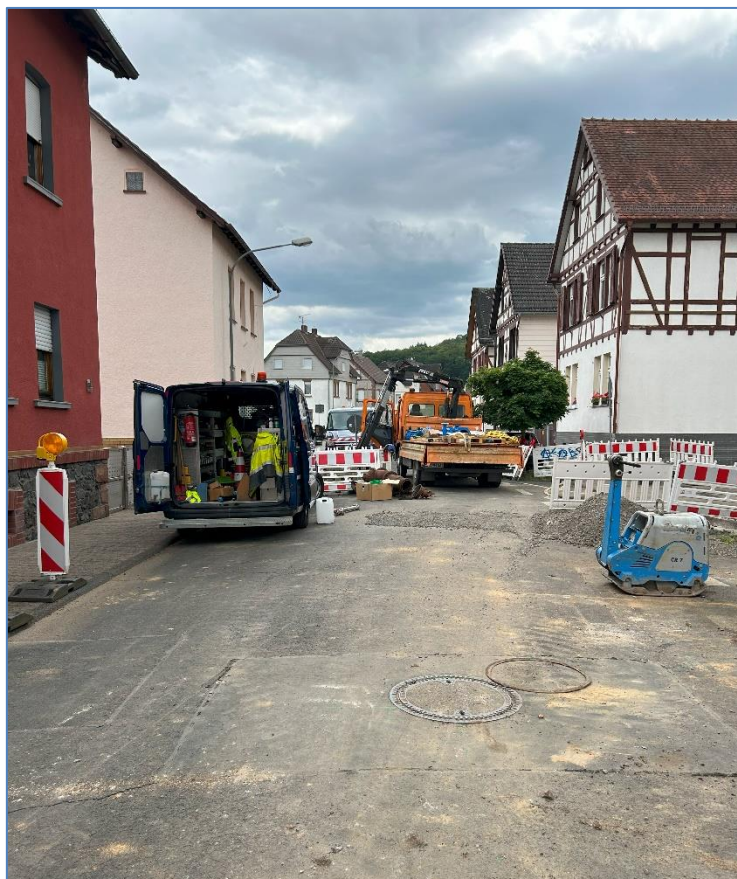
Versorgungsgebiet Kernstadt Lollar Abbruch Schieberschacht und Herstellung erdverlegtes Schieberkreuz unter Vollsperrung in der Lumdastraße
