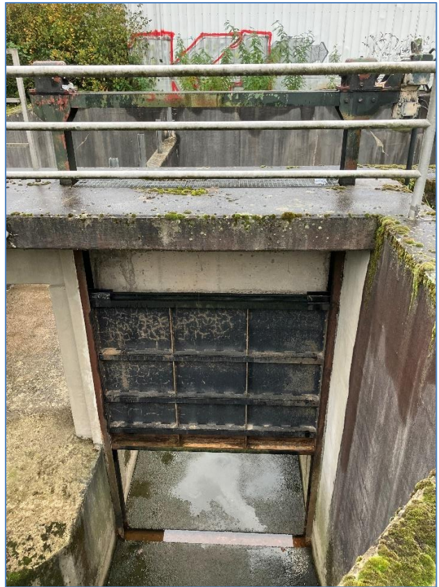
Oben: Darstellung des Hochwasserschützes B 7 "Lumdagarten" für die Fertigung vs. Bestand
