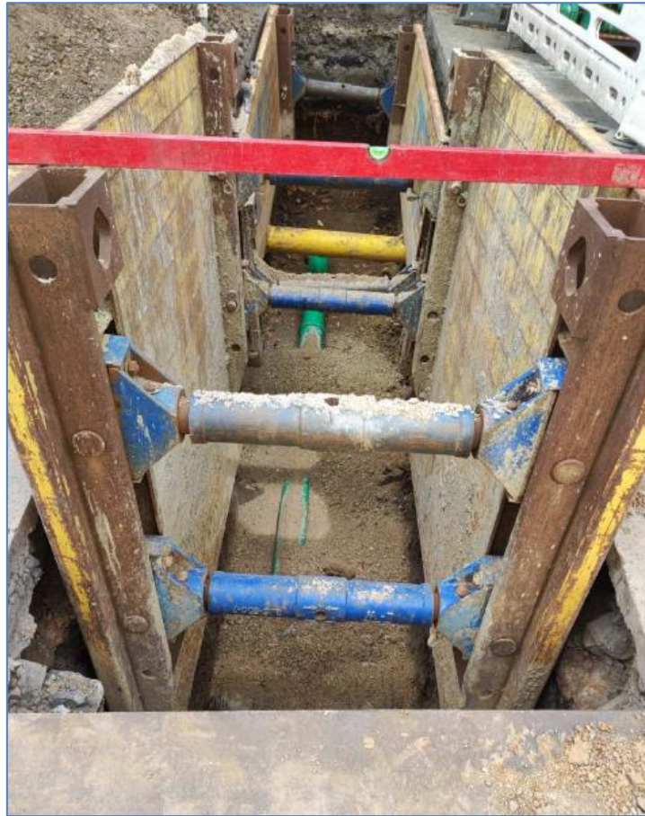
Oben: Blick in verbauten Kanalgraben - Sanierung Hausanschlüsse in der "Lumdastraße" Unten: Einsatz von zeitweise fließfähigem, selbstverdichtendem Verfüllbaustoff
