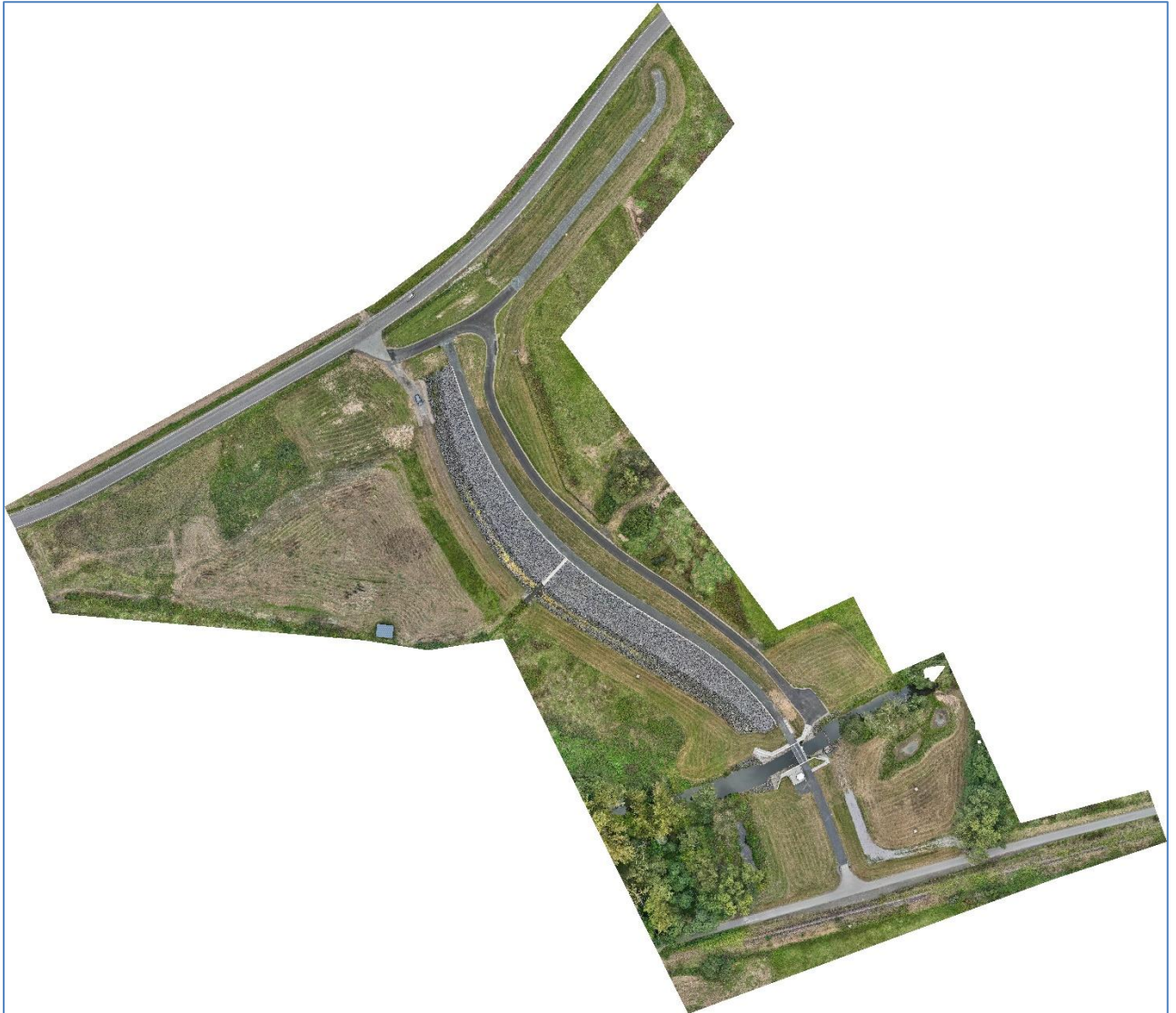
Orthophoto des fertiggestellten HRB Treis vom September 2024
