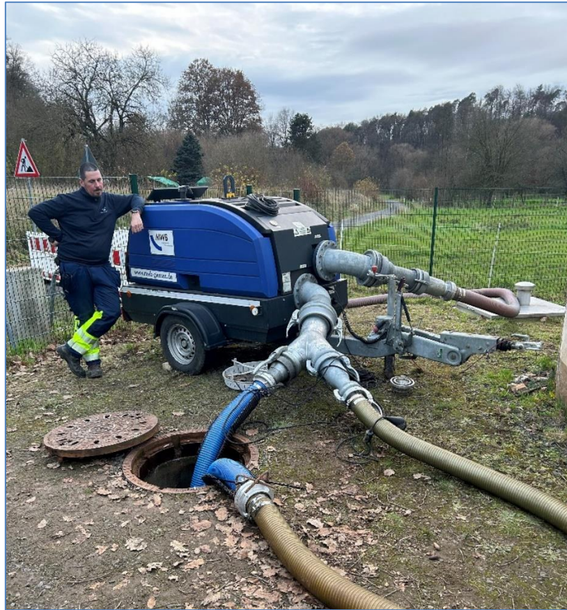
Oben: Blick auf die mobile Abflusslenkung am Pumpwerk B 13 "Treis" während der Bauzeit Unten: Blick auf die erneuerte Strom- und Schaltanlage im Pumpwerk B 7 "Lumdagarten"
