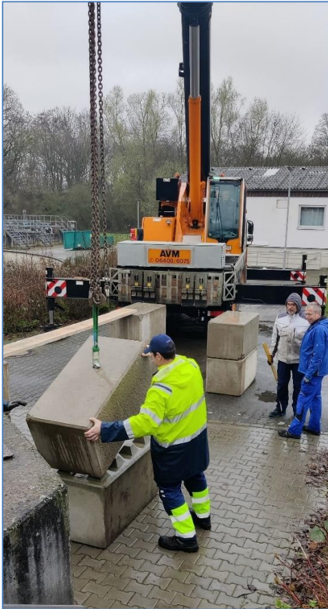
Oben: Ausgleich Höhenunterschied mit Beton-Legos (links)/ Fliegende Leitung (rechts) Unten: Improvisierte Probenahmestelle vor Einlauf in die Belebung
