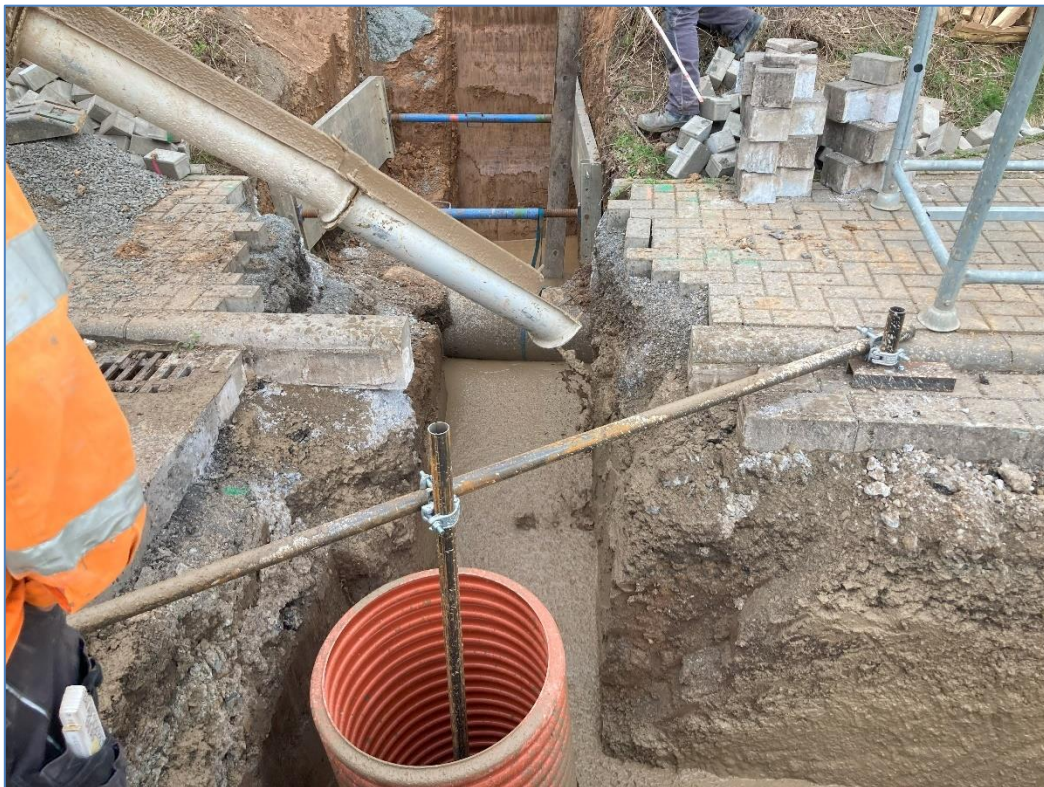
Oben: Blick in verbauten Kanalgraben - Sanierung Hausanschlüsse in der "Lumdastraße" Unten: Einsatz von zeitweise fließfähigem, selbstverdichtendem Verfüllbaustoff
