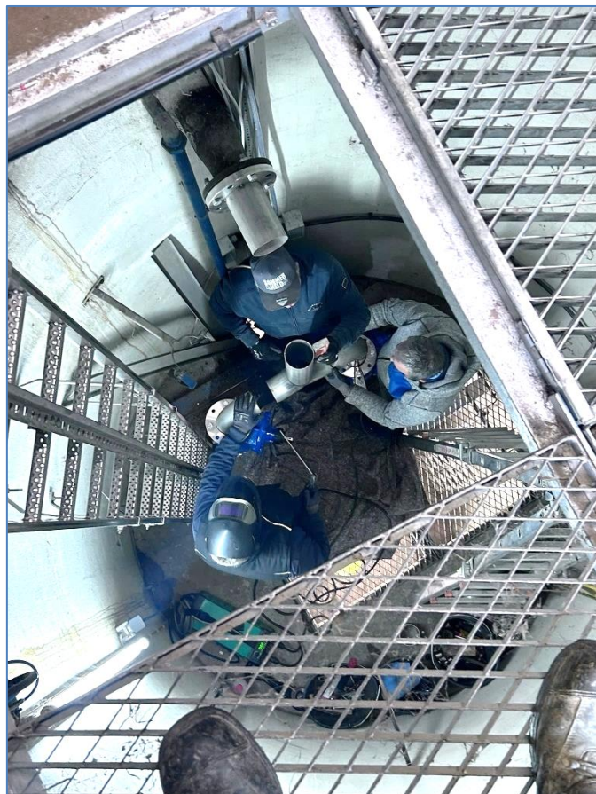
Oben: Blick auf die neuen senkrechten Abwasserpumpen am Pumpwerk B 13 "Treis" Unten: Beengte Verhältnisse im Pumpwerk B 13 beim Einbau des Druckrohrsatzes
