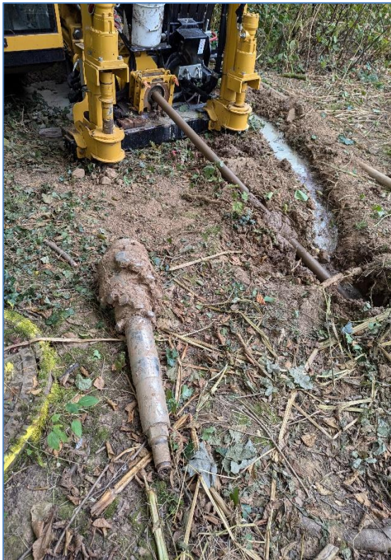
Unten: Spezial-Tiefbau; Felsbohrkopf (links) und Gleitschienenverbau (rechts)
