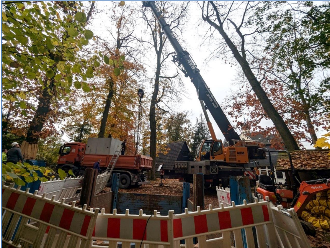
Oben: Beengte Platzverhältnisse beim Kraneinsatz
