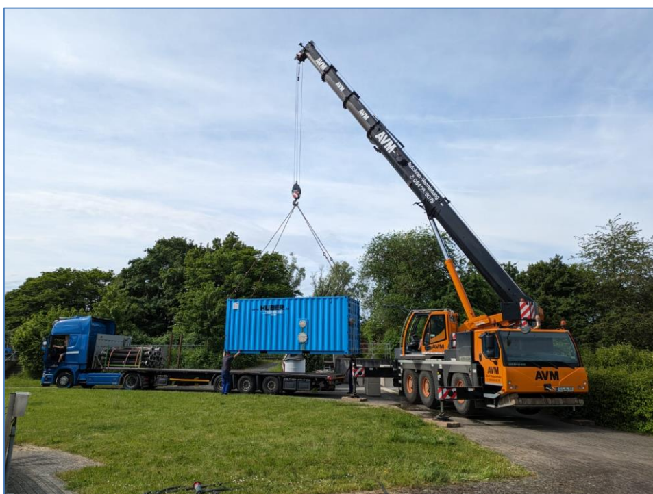
Unten: Aufbau der Versuchsanlage im April 2024
