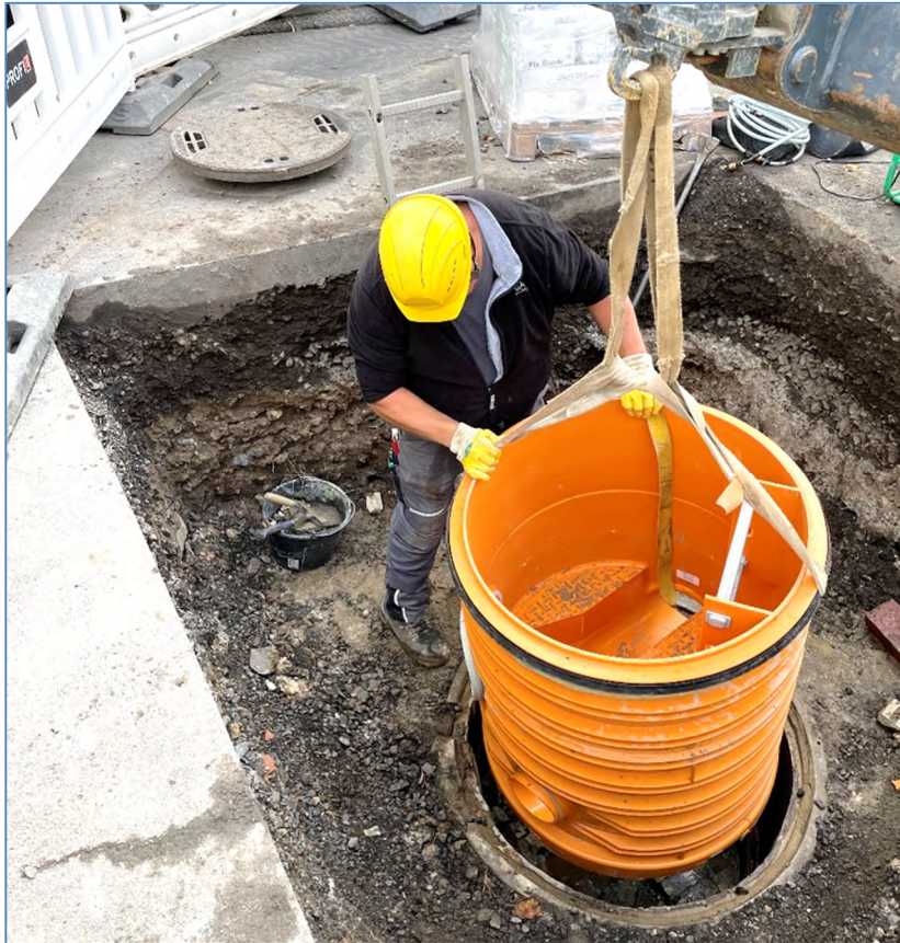
Kanalreparatur in der Bergstraße in der Kernstadt Staufenberg mit Schacht-in-Schacht-System
