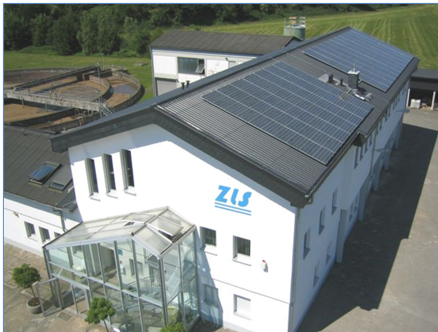
Betriebszentrale Lollar → Photovoltaikanlage
