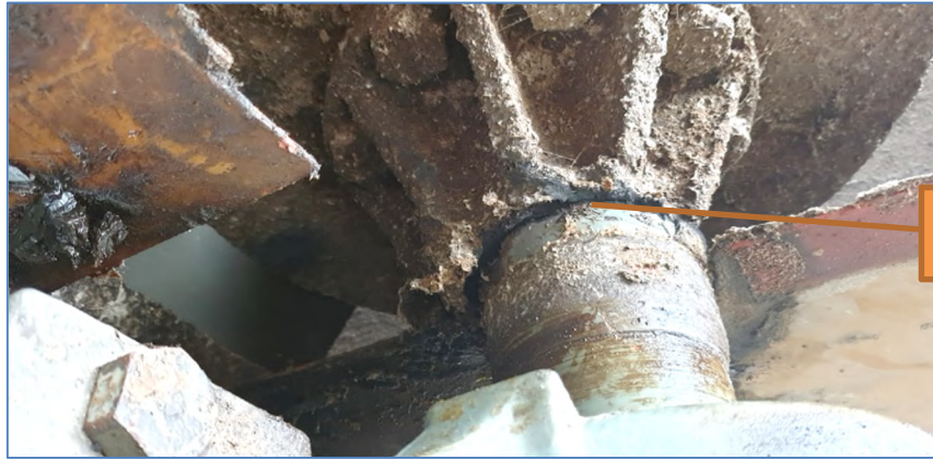
Blick auf das obere Lager - Förderschnecke KA Lollar
