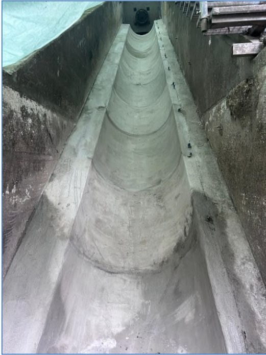
Bilder oben: Betonsanierung Schneckenrog - B 7 Lumdagarten (Trockenwetterschnecke) Bild unten: Montage der werkseitig generalüberholten Trockenwetterschnecke - B 7 Lumdagarten
