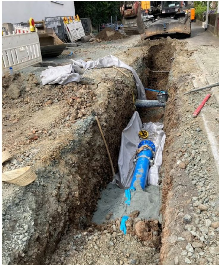
Versorgungsgebiet Kernstadt Staufenberg 1. BA "Bergstraße", Rohrgraben Transportleitung DN 250
