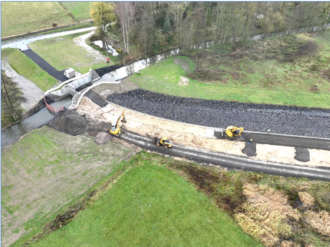
Blick auf die HRB-Baustelle vom 24.11.2023
