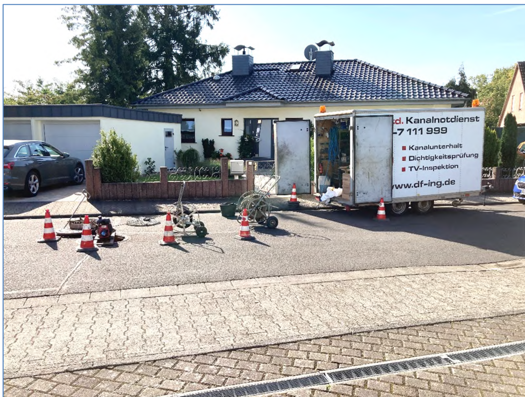
Kanalsanierung Ruttershausen Baustelle von kurzer Dauer und ohne Aufbruch
