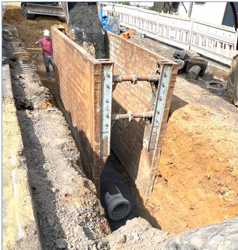
Kanalerneuerung in der Blackenstraße in der Kernstadt Lollar
