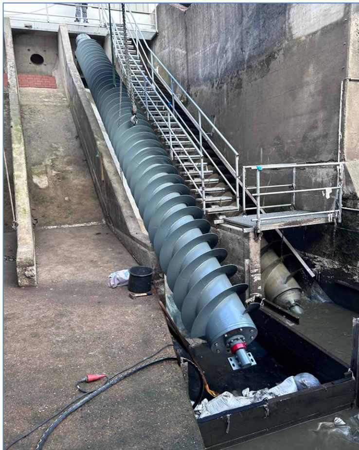
Bilder oben: Betonsanierung Schneckenrog - B 7 Lumdagarten (Trockenwetterschnecke) Bild unten: Montage der werkseitig generalüberholten Trockenwetterschnecke - B 7 Lumdagarten
