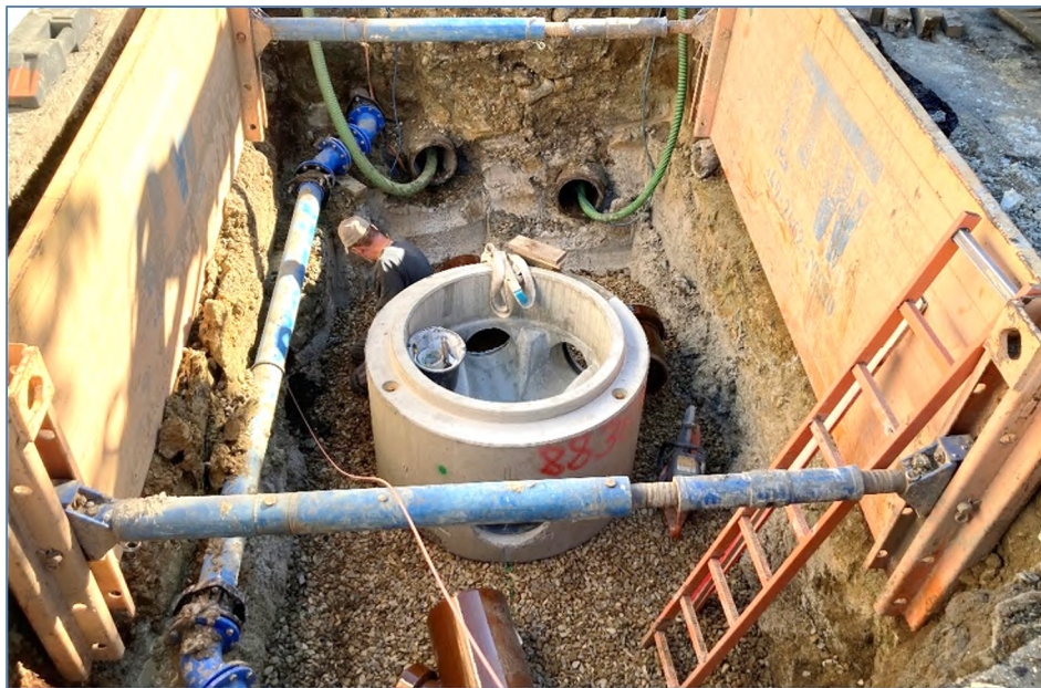
Blick in die verbaute Baugrube in der Schwimmbadstraße
