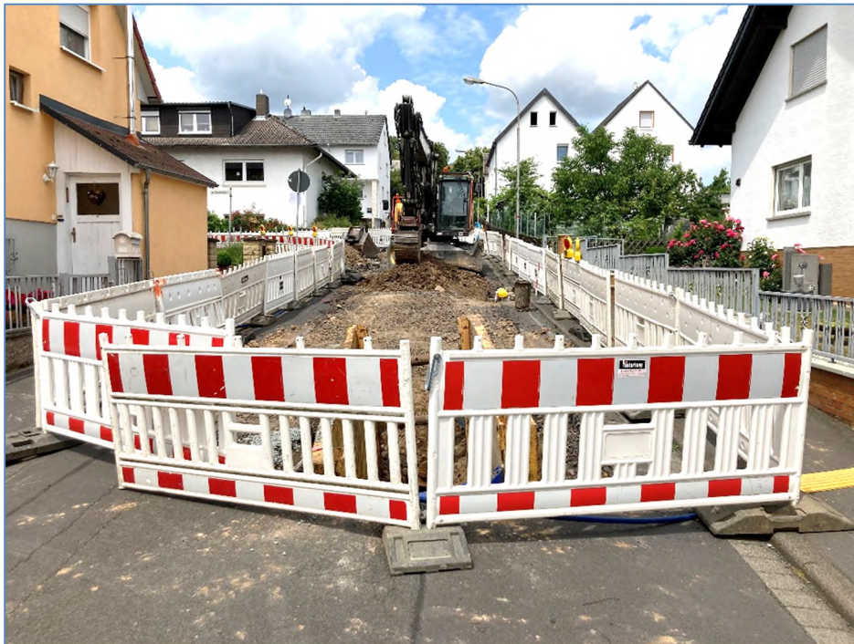
Versorgungsgebiet Kernstadt Staufenberg Erneuerungen der Transportleitung und Versorgungsleitungen 1. BA "Bergstraße"
